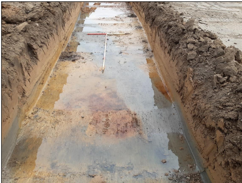
Figuur 6: Aanleg werkput 3: Het grondwater steeg redelijk snel op na de aanleg van de proefsleuf
