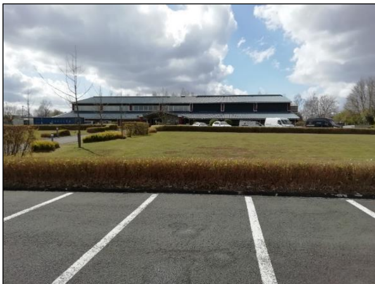
Figuur 5: Foto van het bestaande gebouw, met zicht naar het westen (Initiatiefnemer 2021)
