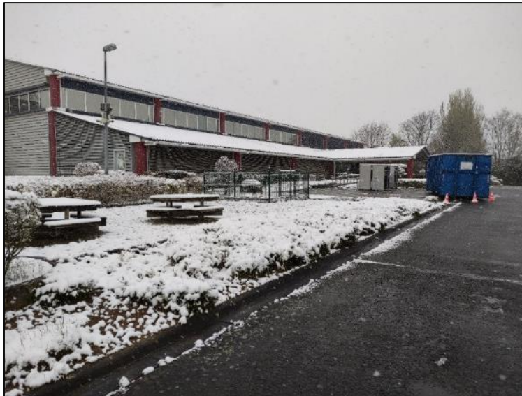
Figuur 4: Foto van het bestaande gebouw, met zicht naar het noordwesten (Initiatiefnemer 2021)
