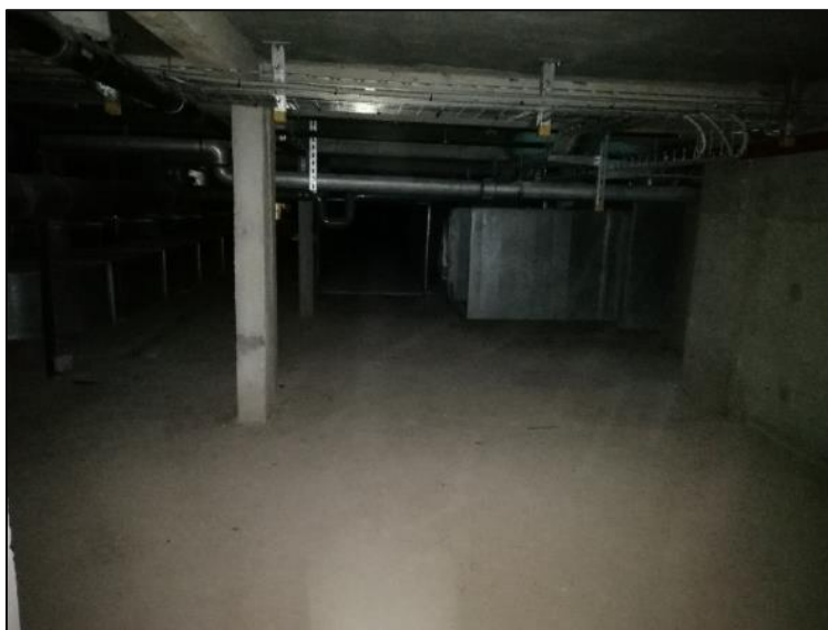
Figuur 6: Foto van de kelders (Initiatiefnemer 2021)
