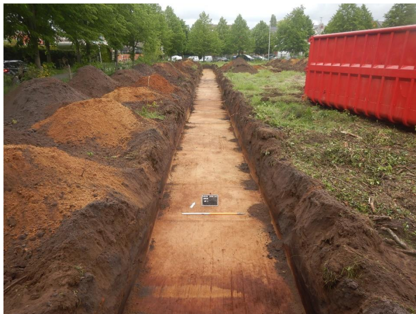
Figuur 17: Overzichtsfoto werkput 3 (ARCHEBO bvba, 2021).
