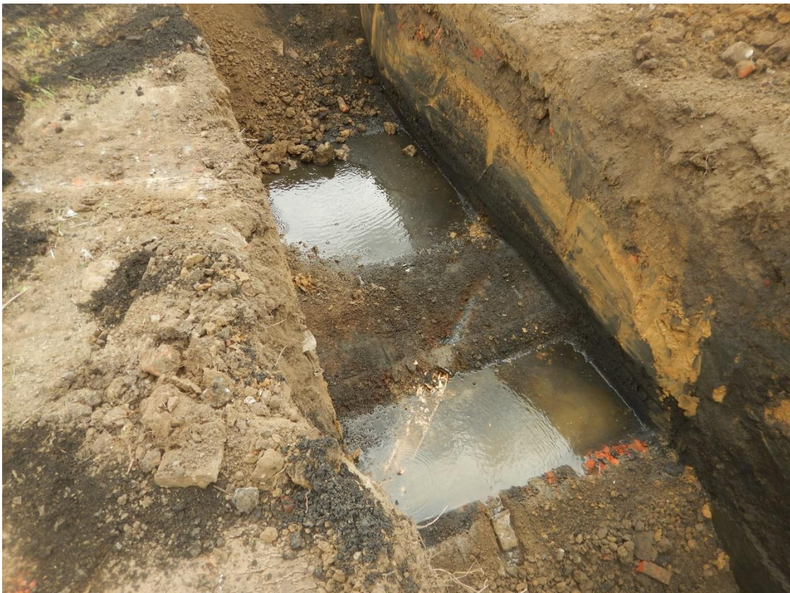
Figuur 43: Zicht op de afvoerbuis en verstoringen in vlak en sleufwand (©MVDK).
