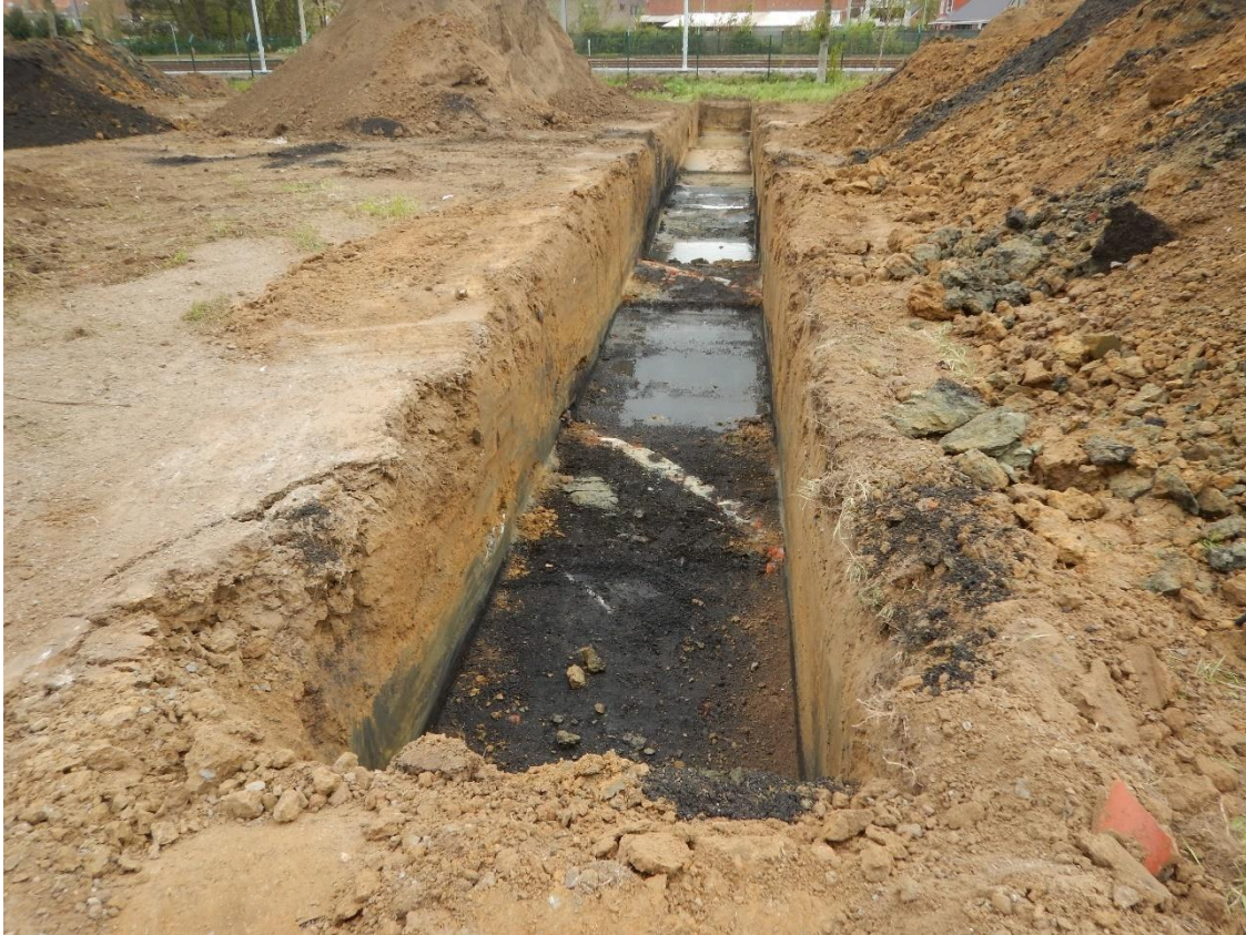
Figuur 36: Zicht naar het noorden over werkput 5 (©MVDK).
