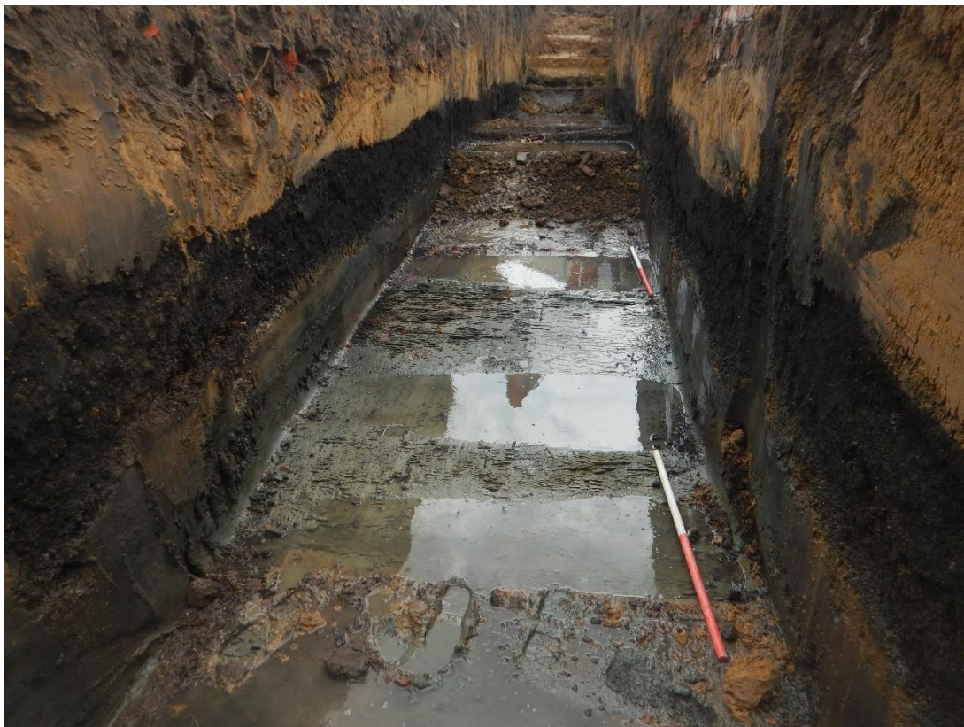
Figuur 41: Zicht naar het zuiden in werkput 6. Het verhoogde deel in de achtergrond is de versterking van de afvoerbuis zichtbaar in onderstaande Figuur 42 (©MVDK).
