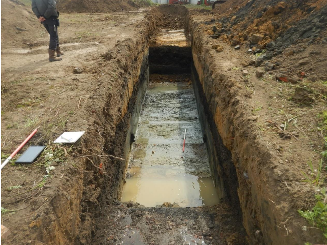
Figuur 39: Zicht naar het zuiden over de noordkant van werkput 6 (©MVDK).
