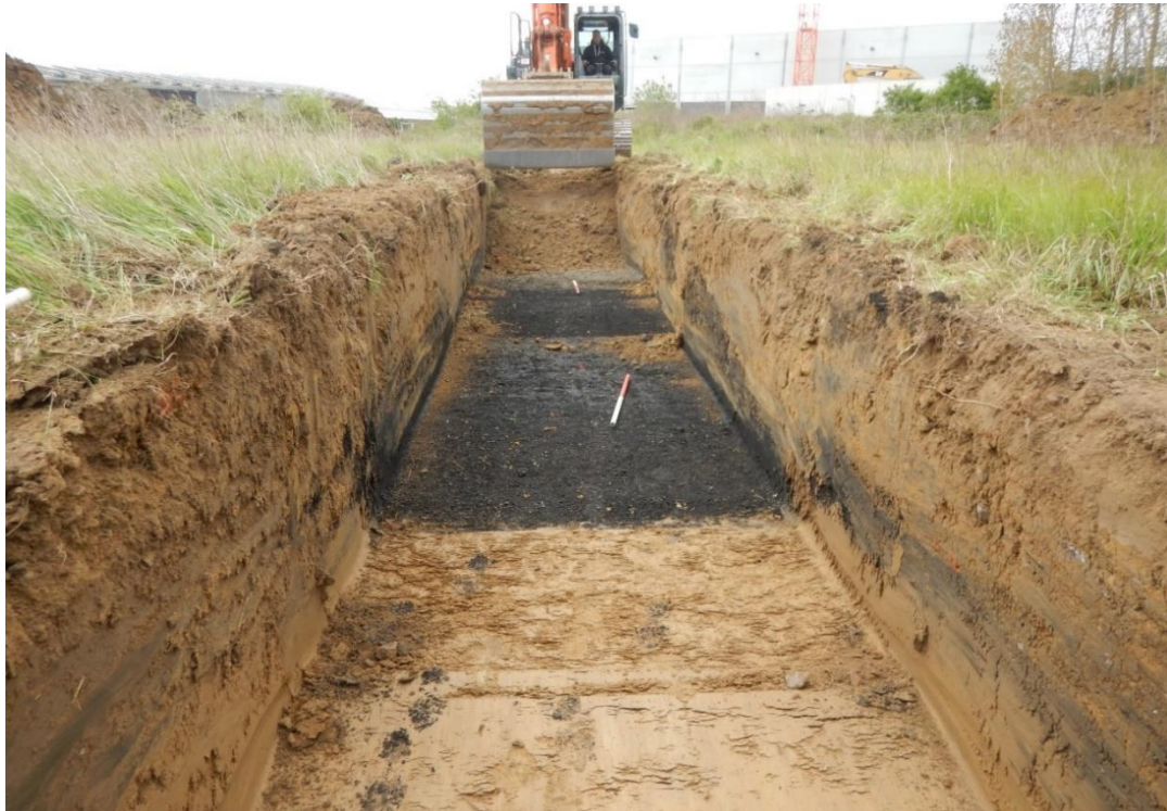
Figuur 29: Zicht naar het zuiden toe over werkput 3. Te zien is de steenslag verstoring zichtbaar in de achtergrond van voorgaande Figuur 28 (©MVDK).
