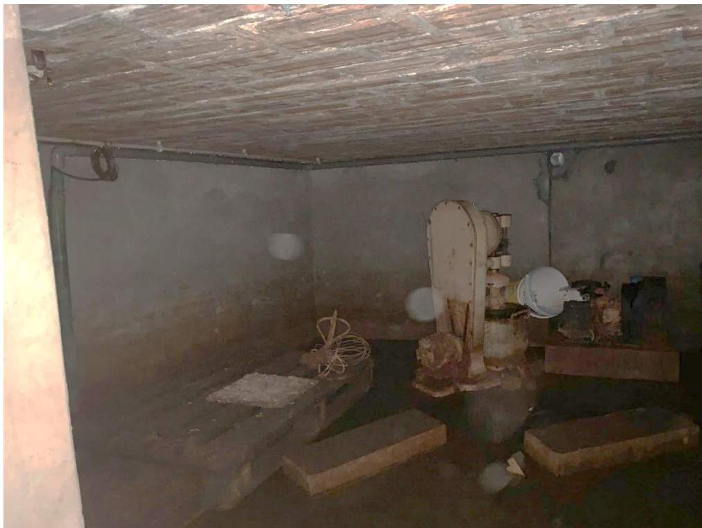
Figuur 4: Bestaande kelder ter hoogte van huisnummer 21. 12
