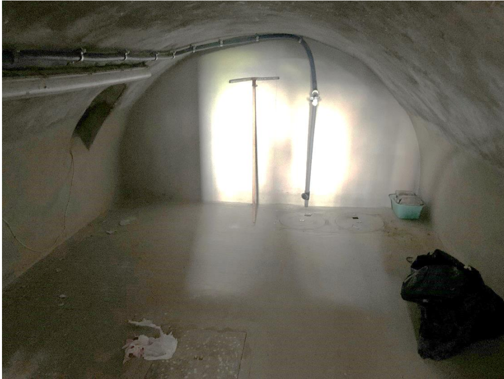
Figuur 3: Bestaande kelder ter hoogte van huisnummer 23. 11
