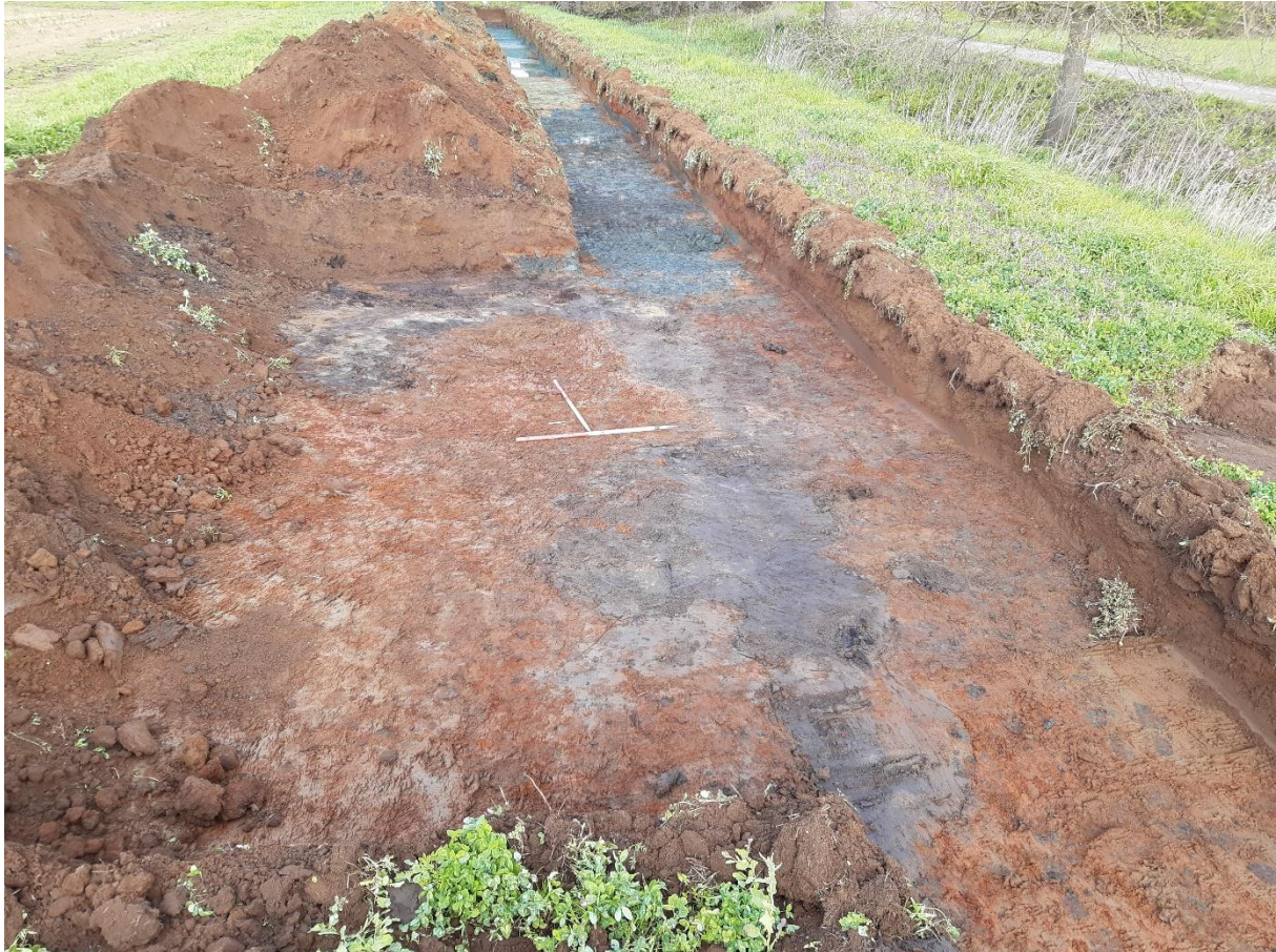
Figuur 30: Aanleg van kijkvenster in werkput 1
