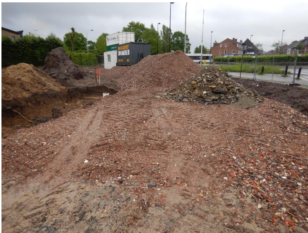
Figuur 14: Werkfoto werfweg in grind ter hoogte van werkput 1
