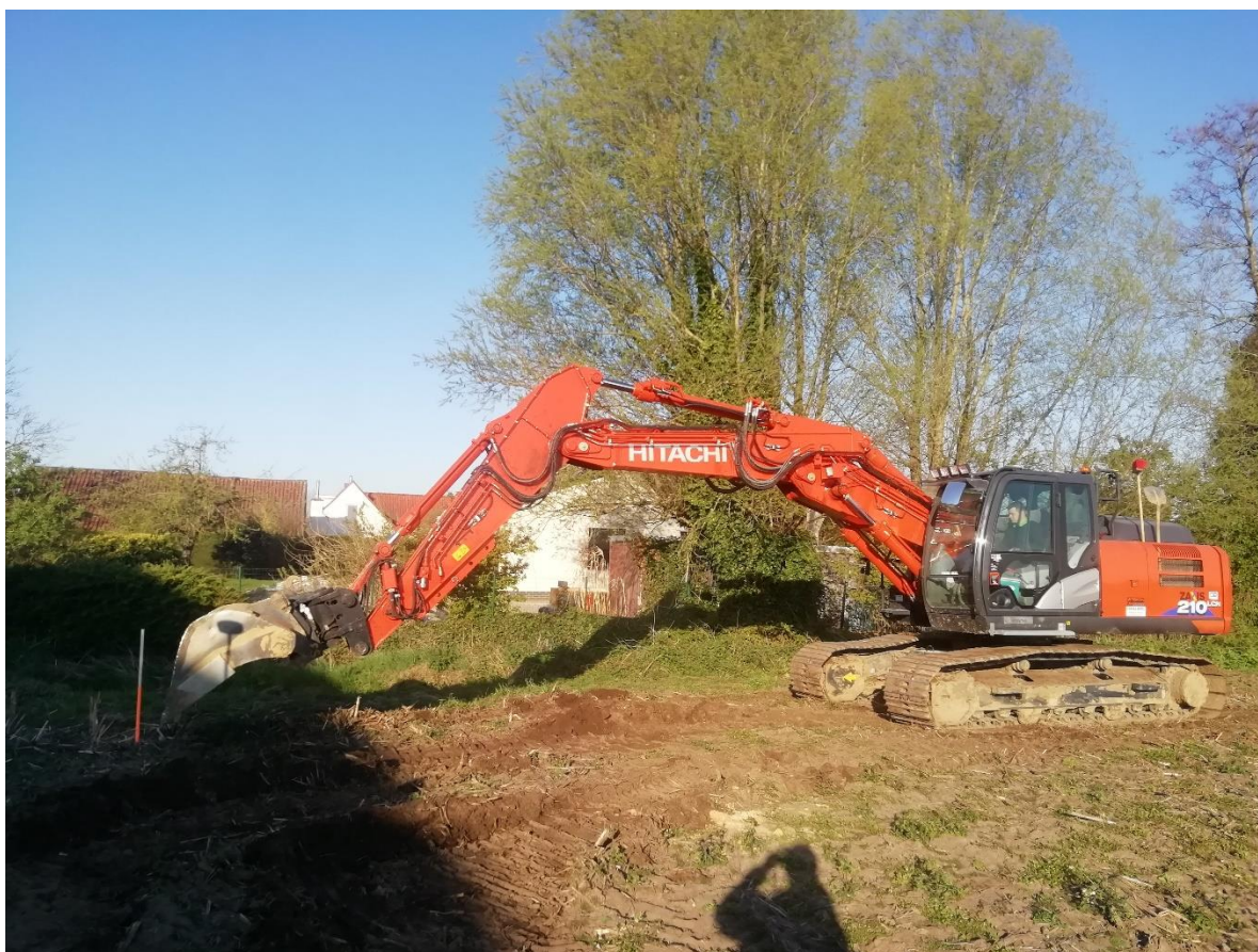
Figuur 6: Start van sleuf 1, in het zuidwesten van het projectgebied.
