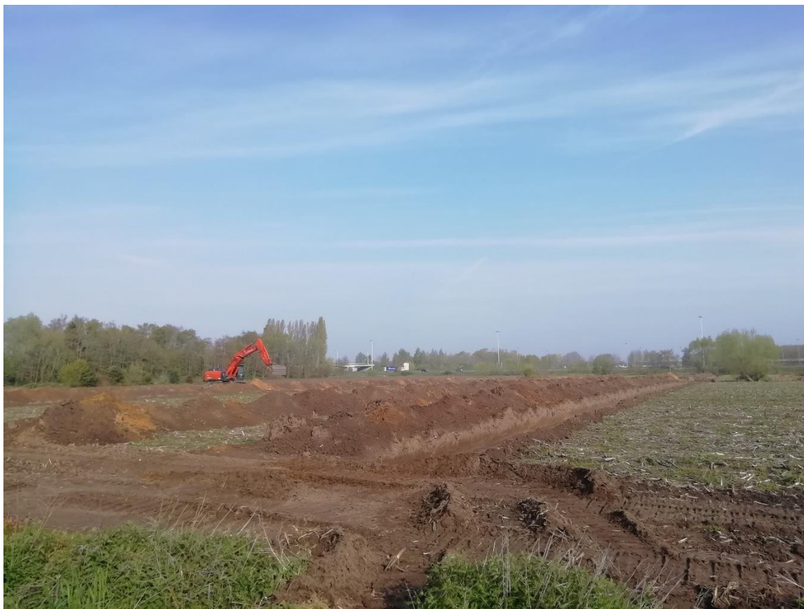
Figuur 13: Westelijk en centraal gelegen sleuven en dichten ervan op 30/04/2021.
