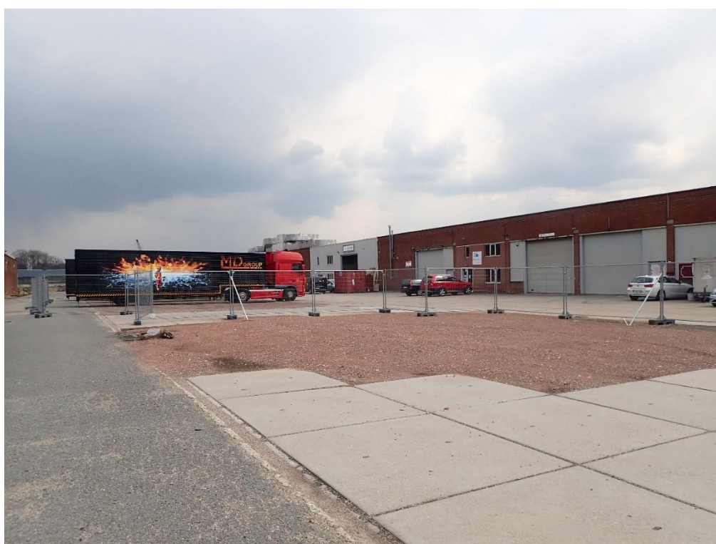
Figuur 45: Zicht op verharding (© J. Verrijckt Bvba).
