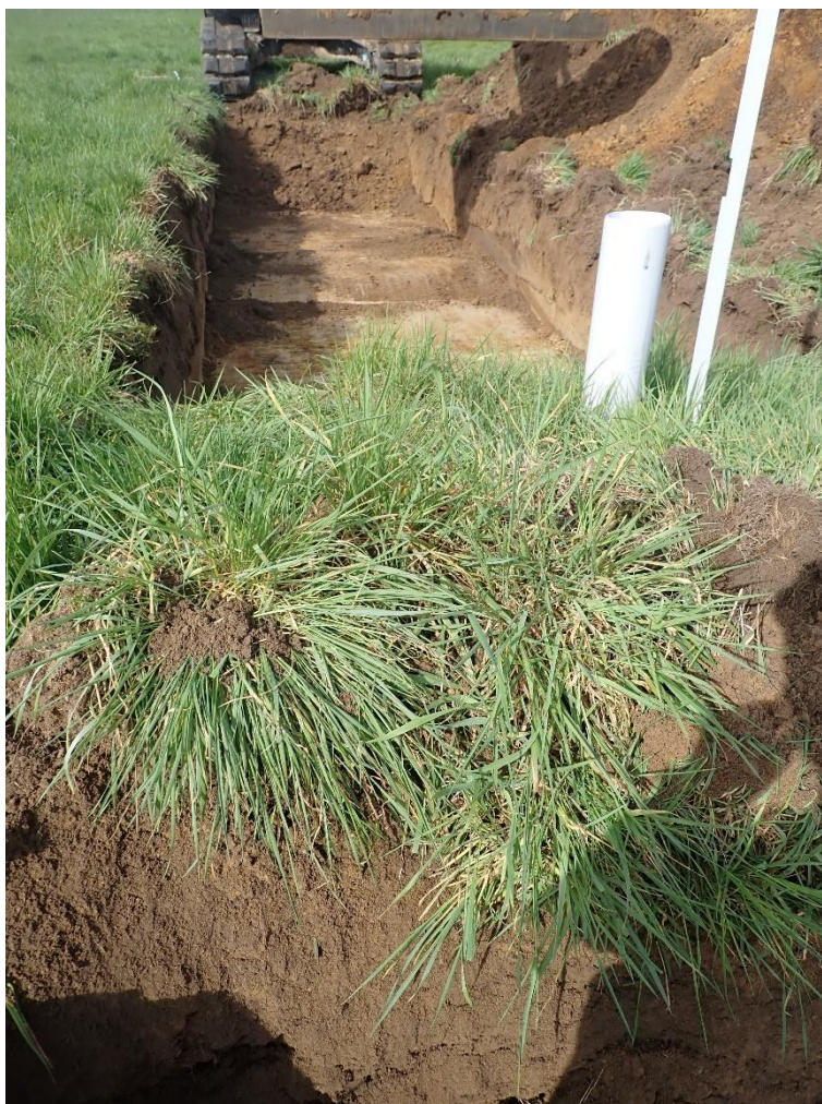
Figuur 88: Peilbuis in werkput 3 (© J. Verrijckt Bvba).
