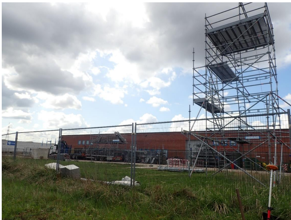
Figuur 44: Zicht op de aanwezige stellingbouw (© J. Verrijckt Bvba).
