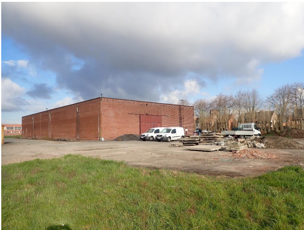
Figuur 42: Zicht op het bestaande gebouw met verharding (© J. Verrijckt Bvba).
