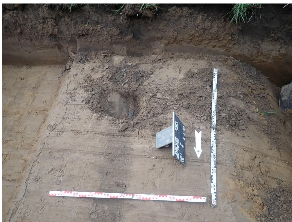
Figuur 85: Bestaande leiding in werkput 1 (© J. Verrijckt Bvba).
