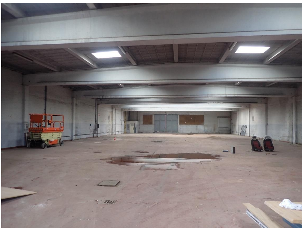
Figuur 43: Binnenzicht van het bestaande gebouw met betonnen verharding (geen kelder aanwezig) (© J. Verrijckt Bvba).
