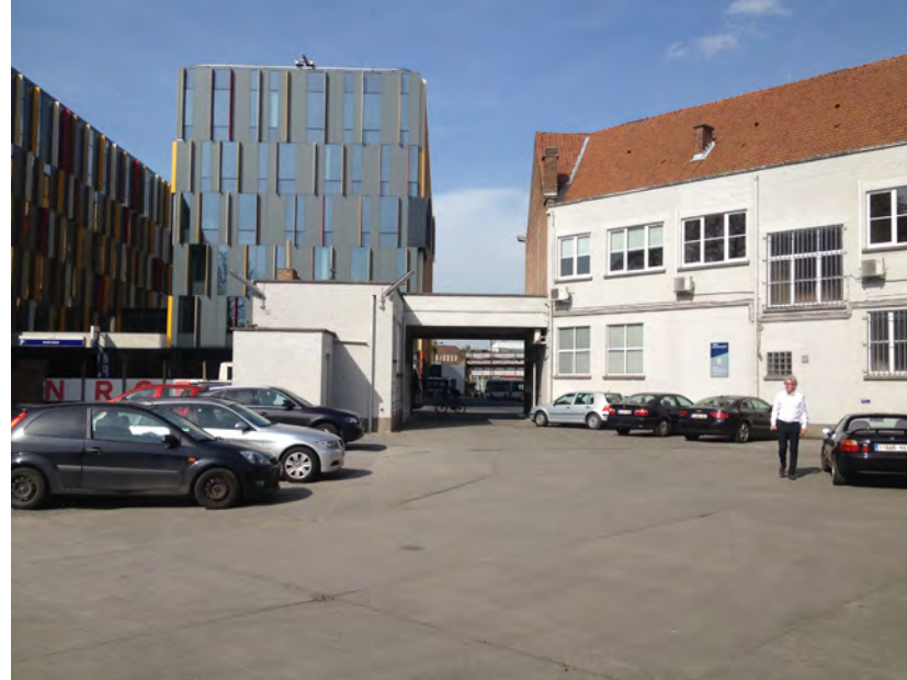
HUDIG GEBOUW CARGLASS
