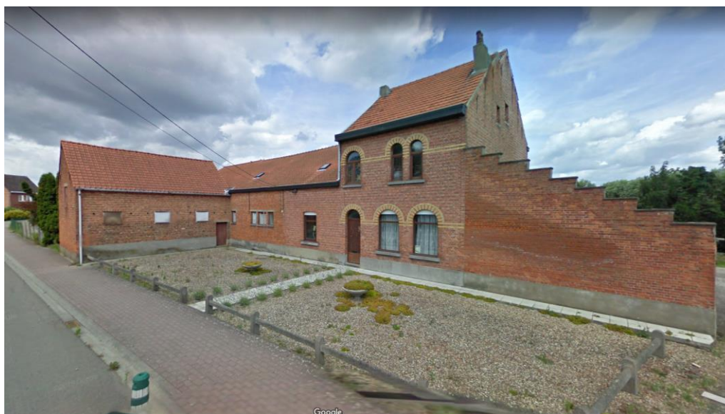
Figuur 3: Orthofoto van de huidige toestand (Google streetview)
