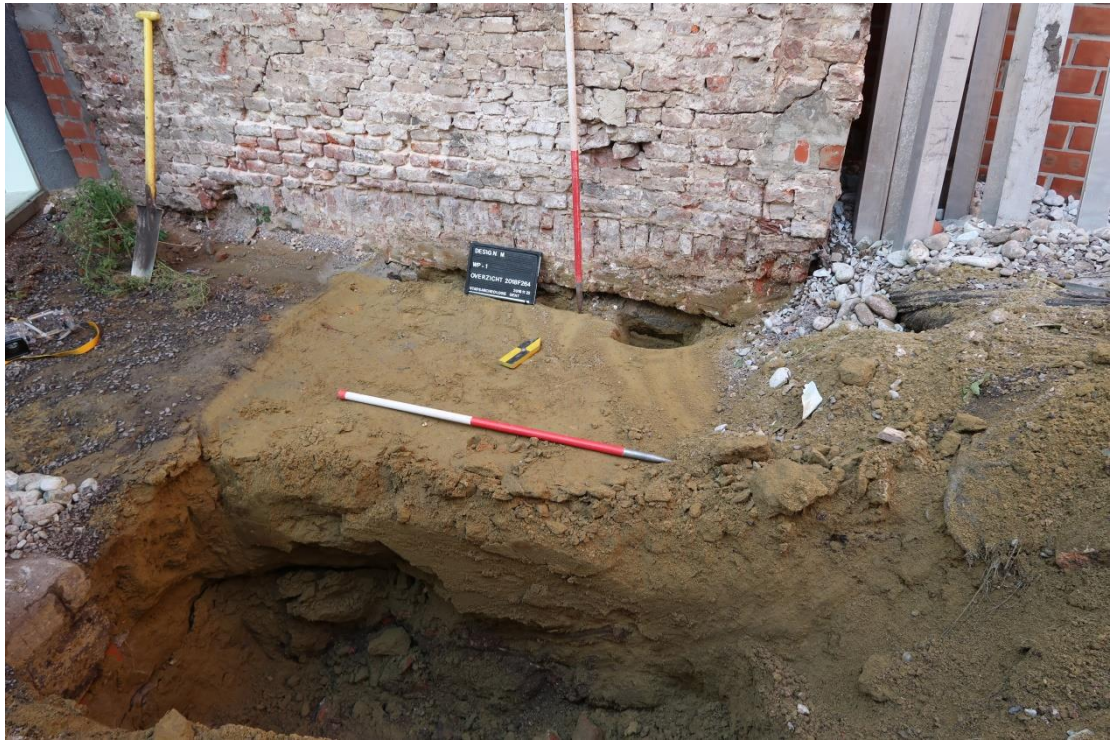
Figuur 28: Overzicht van WP1, met zicht op de niet gefundeerde achtermuur en de inkalvende wanden (Stad Gent, De Zwarte Doos, Stadsarcheologie)
