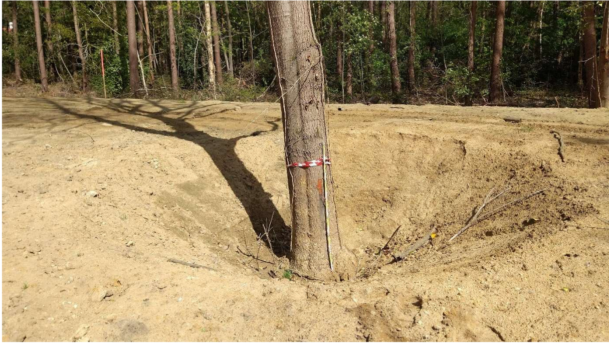
Figuur 8. Detailfoto met te behouden boom in de oostelijke zone van het te bebouwen terrein en het verschil van het huidige (opgehoogde) niveau met het oorspronkelijke maaiveld. ©LARES
