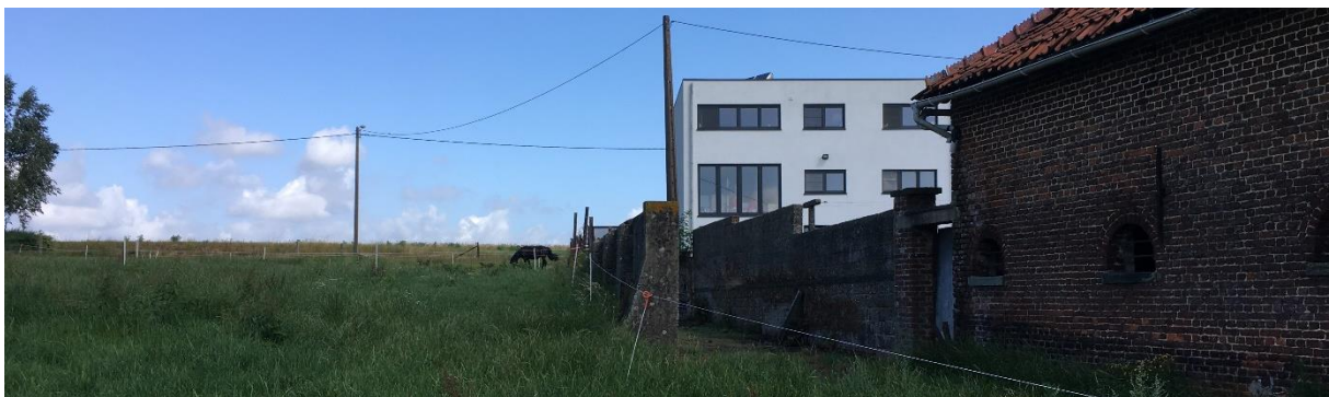
Figuur 11 : Zicht op het plangebied ter hoogte van boring 1, gezien vanuit het zuiden.
