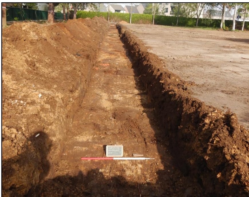
Figuur 17 Zicht op een verstoorde zone in sleuf 1.
