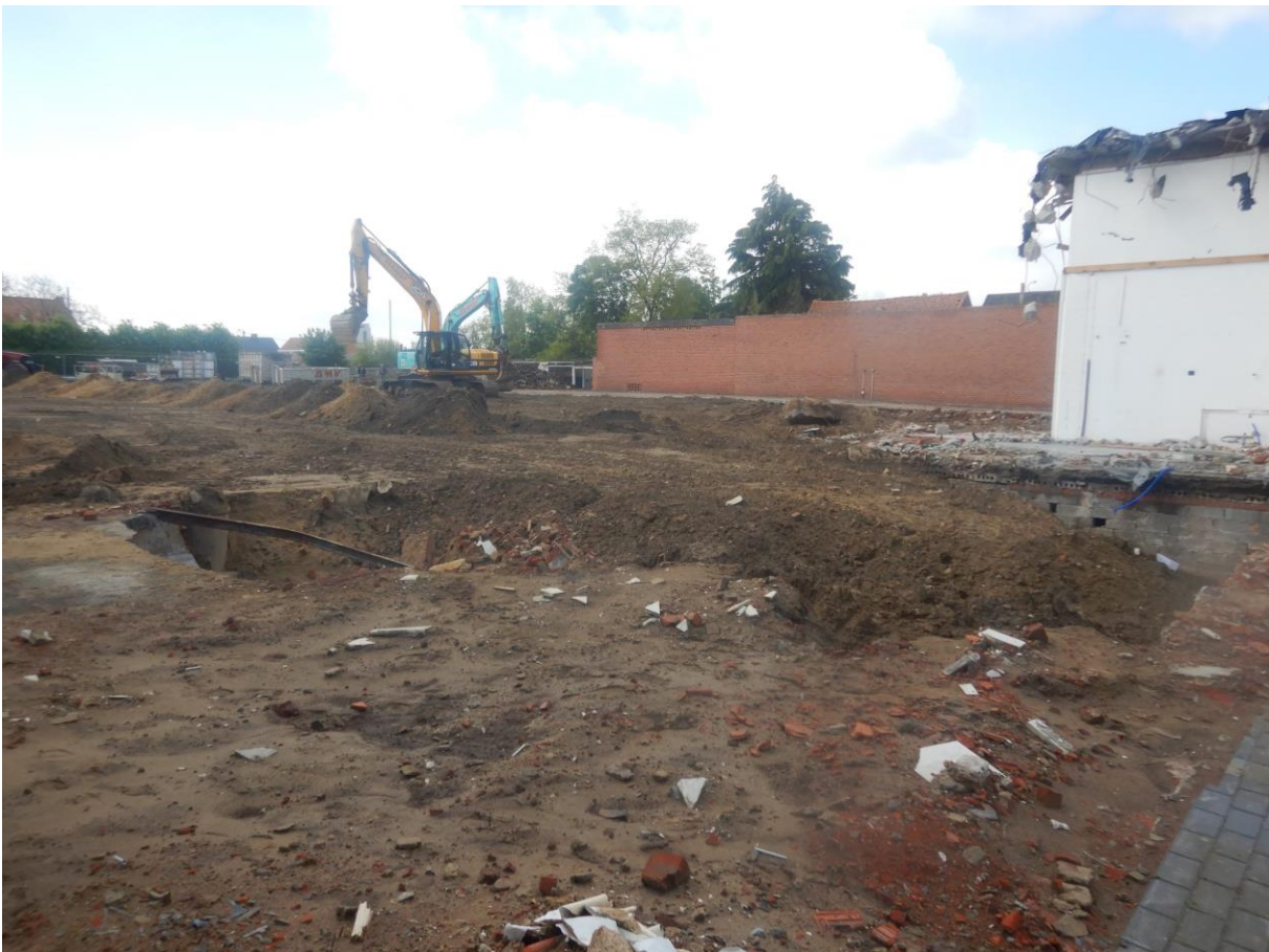
Figuur 23: Kelder en gebouwrestant ter hoogte van nr 155 en nog restant van gebouw nr. 157
