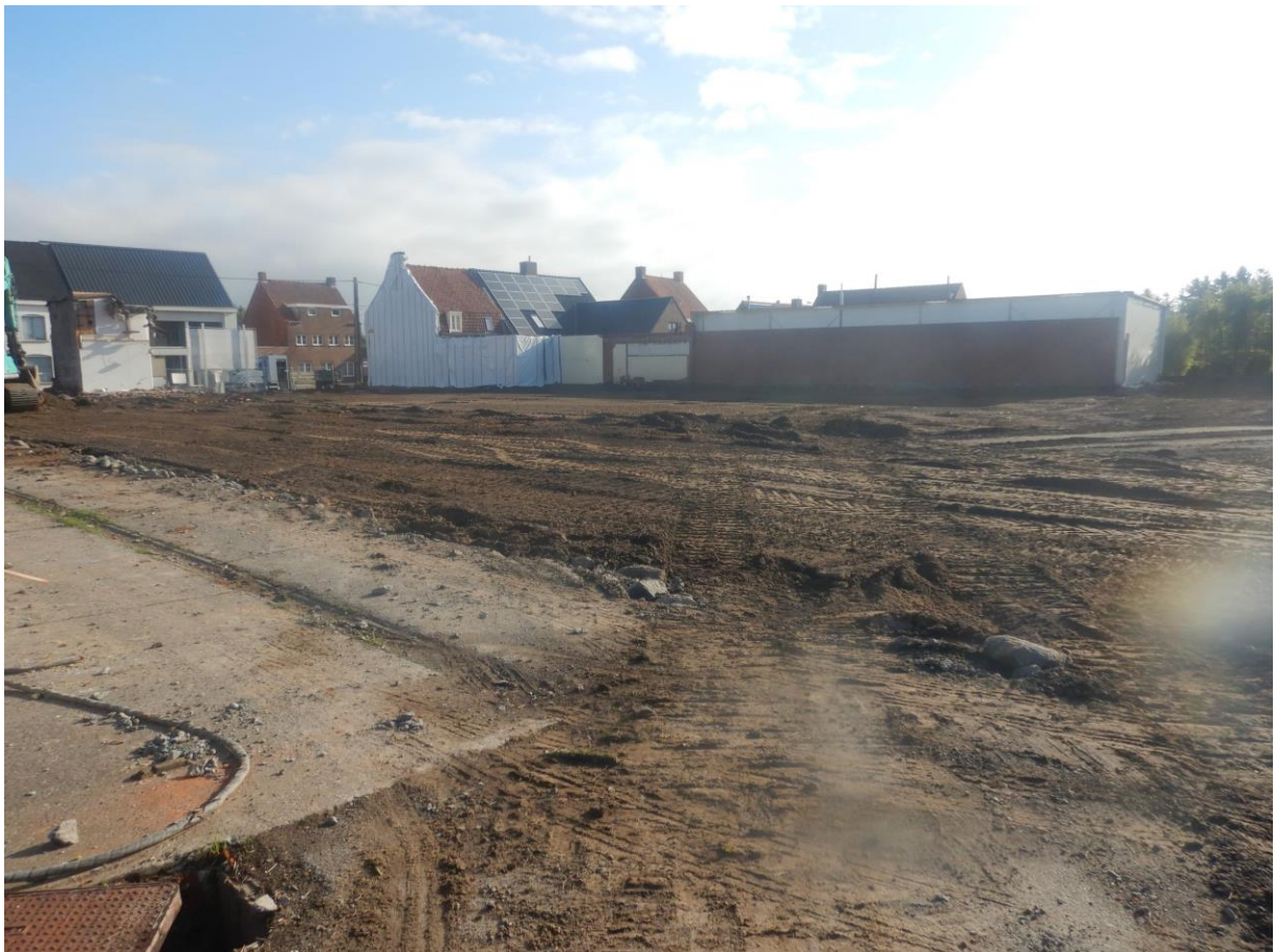
Figuur 25: Toestand voor aanvang centrale deel van het terrein.
