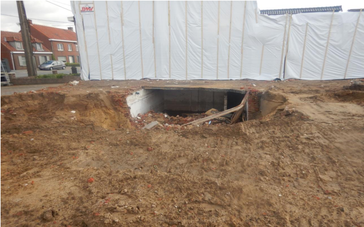
Figuur 22: Kelder aan de Ingelmunstersteenweg, ter hoogte van het voormalige huisnr 153
