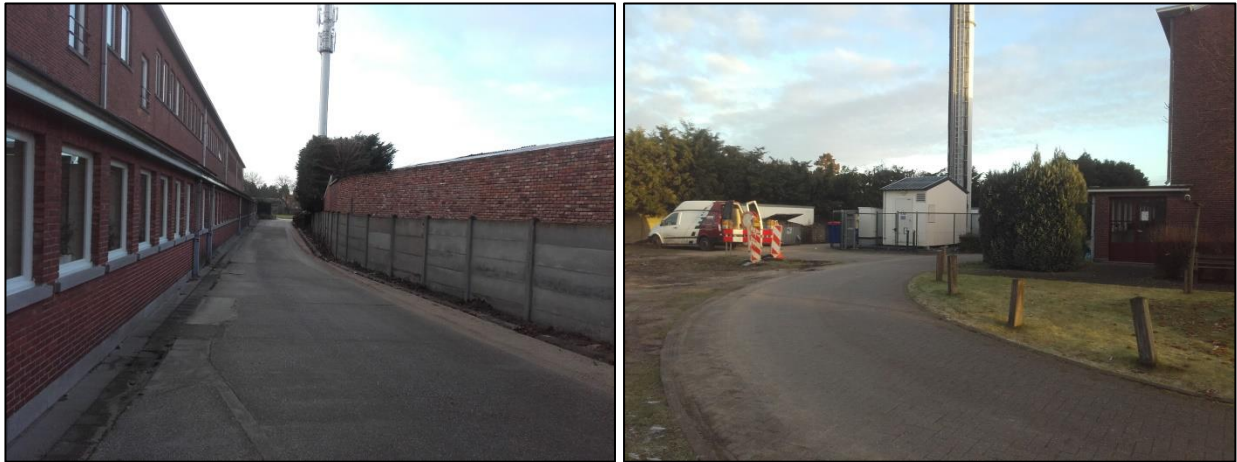
Foto 1: Zicht op de toegangsweg naar het achter terrein van het Onze-Lieve-Vrouw zorgcentrum. Links op de foto het te slopen deel van het woonzorgcentrum. Op de achtergrond de UMTS-mast (d.d. 05-01-2017).
