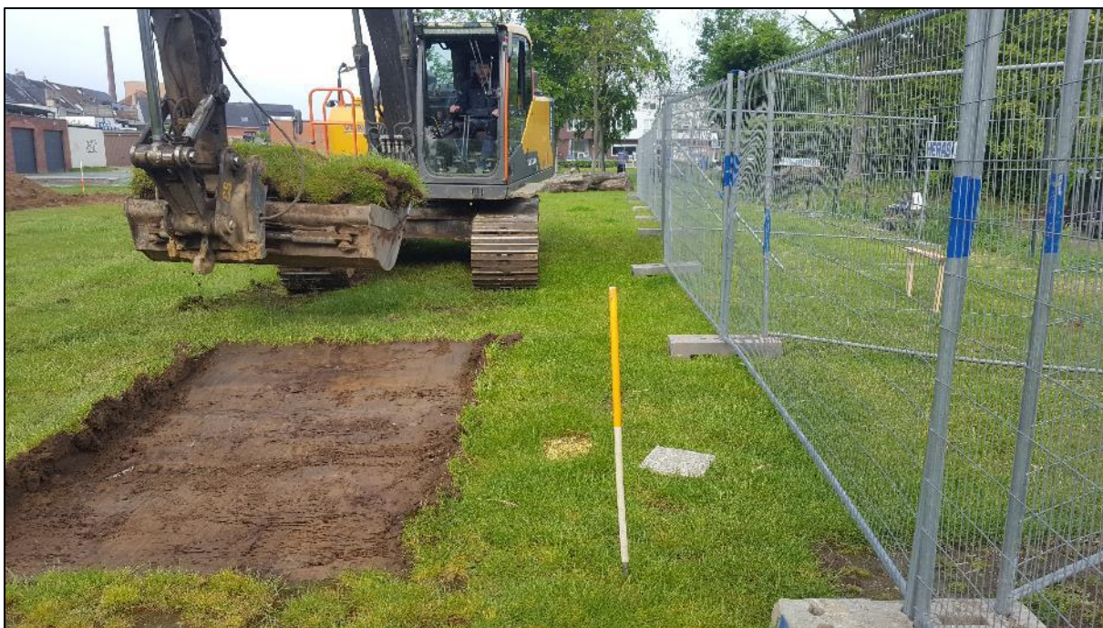
Figuur 22: Terreintoestand op 27 mei 2021, zicht op de Herashekken langs de noordelijke rand van het terrein. Foto genomen in westelijke richting (ABO nv 2021)
