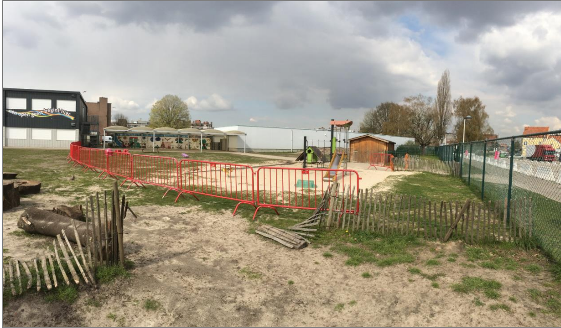
Figuur 12. Noordelijke zone van het plangebied. Voorgond: speelterrein, achtergrond: te verwijderen gebouwen in de nieuwbouwzone (Foto: Triharch 14/04/2021)
