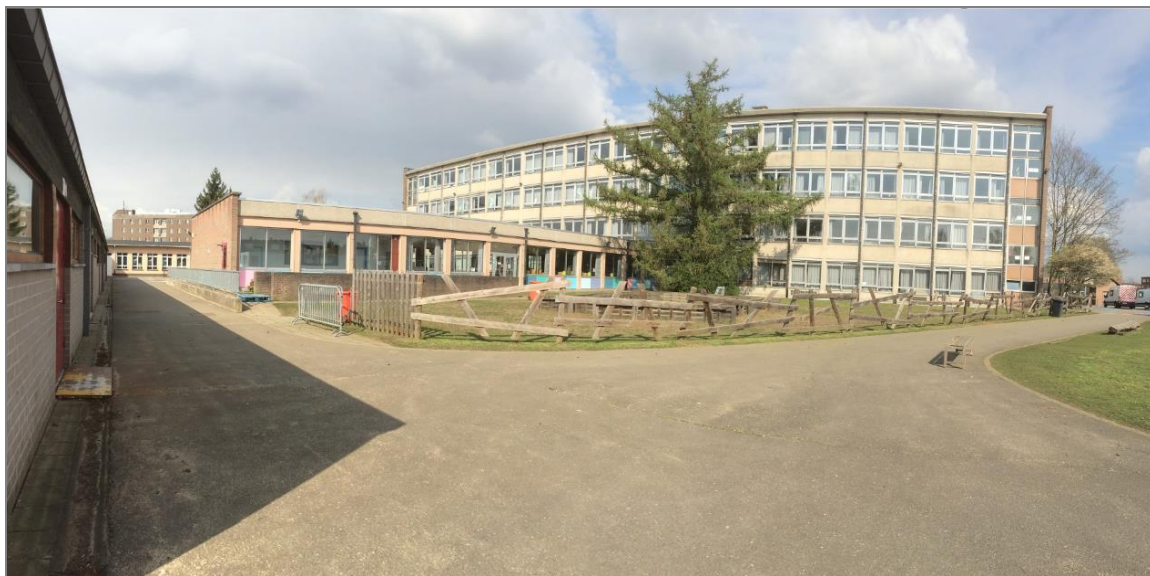
Figuur 5. ZN-zicht op het hoofdgebouw dat gerenoveerd zal worden. Voorgrond: de te slopen zuidvleugel van het hoofdgebouw. (Foto: Triharch 14/04/2021)
