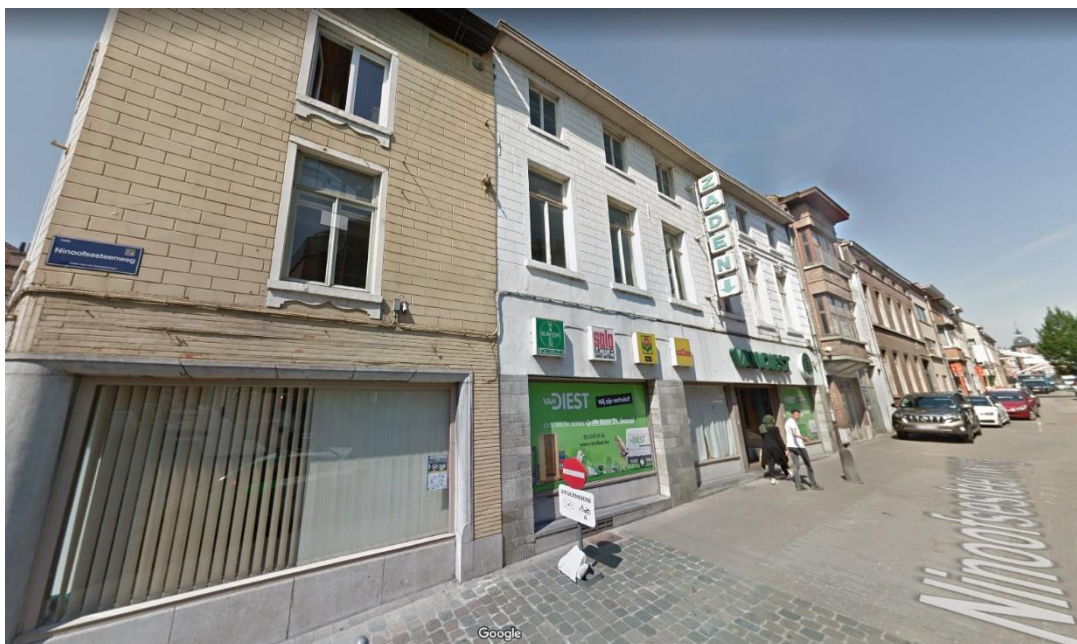
Figuur 1: Zicht op de panden aan de Ninoofsesteenweg 9
