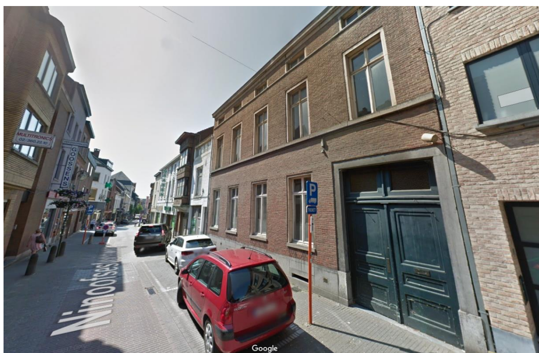
Figuur 2: Zicht op de panden aan de Ninoofsesteenweg 10
