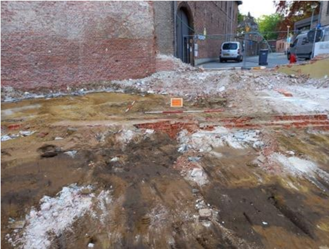
Afb. 22. Zicht op de gesloopte muur S1 ter hoogte van het maaiveld.
