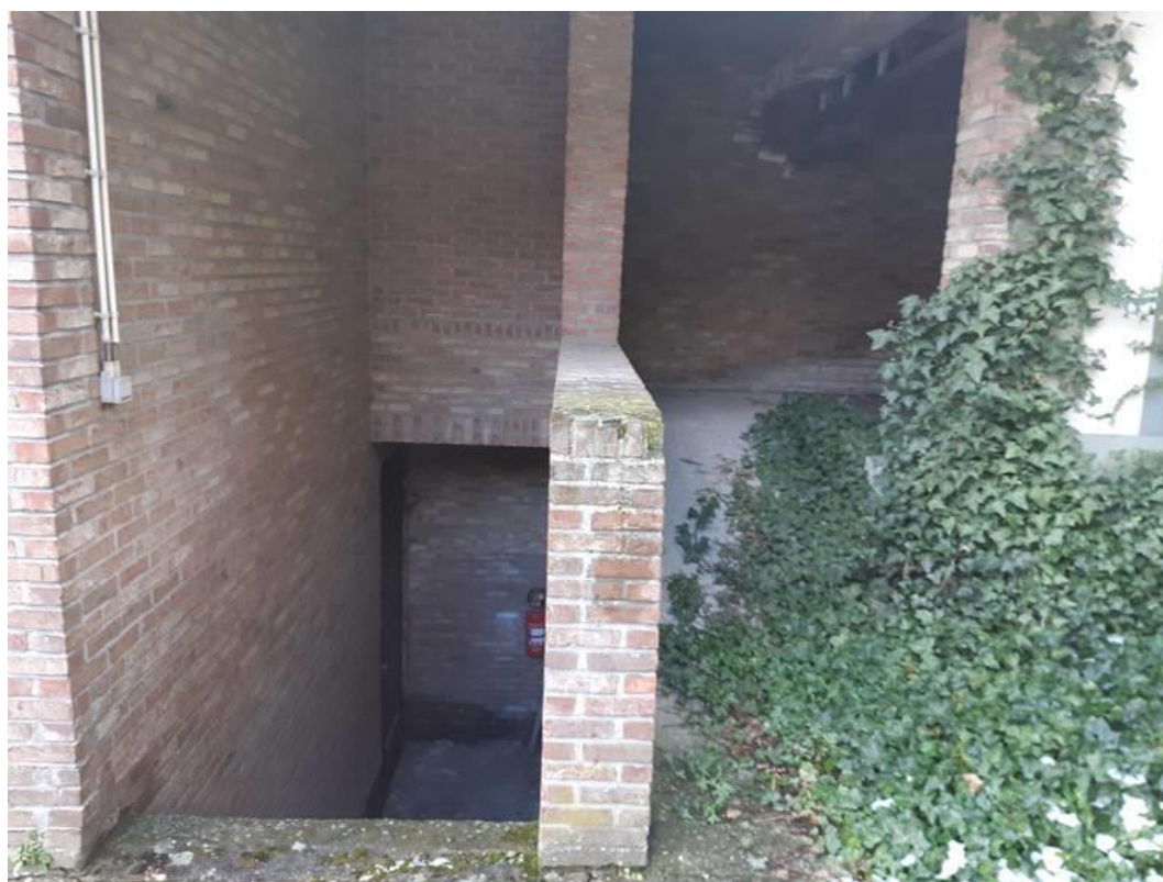
Figuur 8: Foto ingang kelder bestaande stookplaats 6
