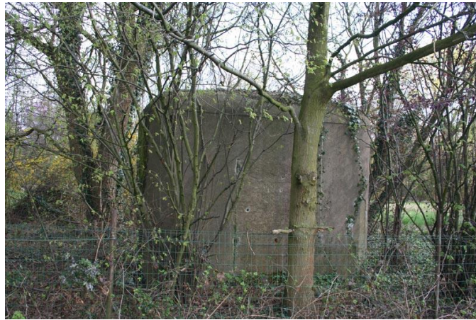
Figuur 24: Connectiekamer op het terrein (VA17) (deze was reeds gesloopt bij aanvang van het onderzoek) 13
