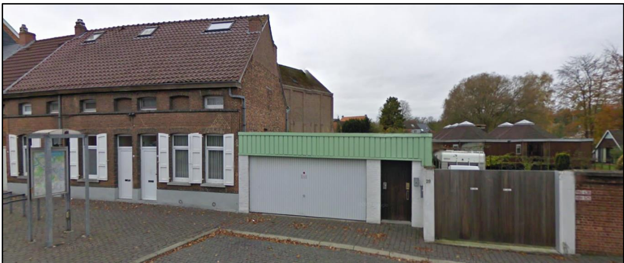
Figuur 1 Zicht op de bestaande arbeiderswoningen nr. 21, 23 en 25 met centraal de garagebox. Rechts achteraan is de achterliggende woning nr. 29 te zien.
