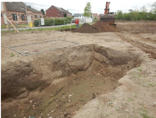
Figuur 19: Uitgegraven kelder Broechemsesteenweg 72 (Archebo bvba, 2021)
