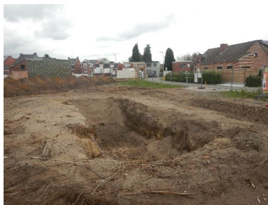
Figuur 21: Uitgegraven kelder Willibrordusstraat 3 & 5 (Archebo bvba, 2021)
