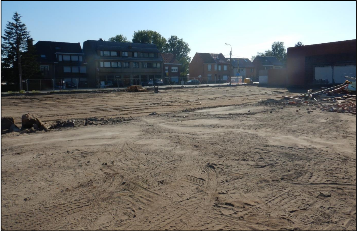
Figuur 4 Sfeerbeeld van het terrein na de sloop en oppervlakkige opbraak van de verhardingen (na fase 1 en bij aanvang van fase 2).
