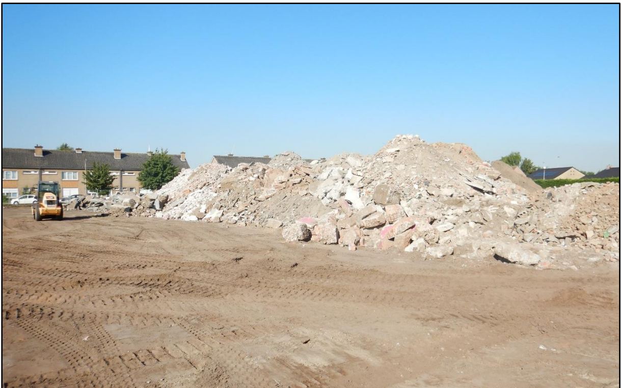
Figuur 3 Stockage van het breekpuin na fase 1 en voor fase 2.
