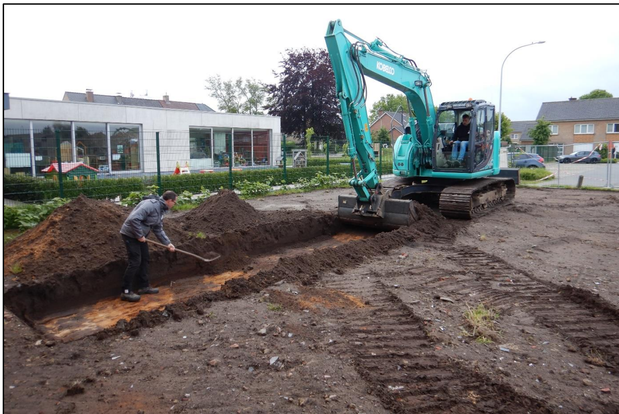
Figuur 9 Sfeerbeeld bij de aanleg van de proefsleuven (fase 1).
