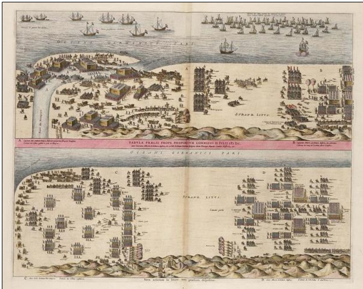
Figuur 21: prent van de Slag bij Nieuwpoort 77
