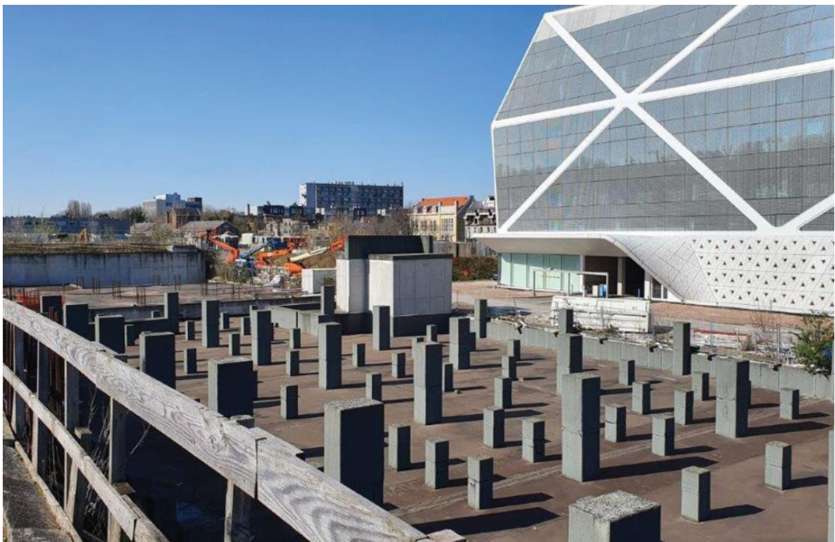
Figuur 2: Zicht op plangebied ter hoogte van de ondergrondse parking, vanaf de Boentweg 5
