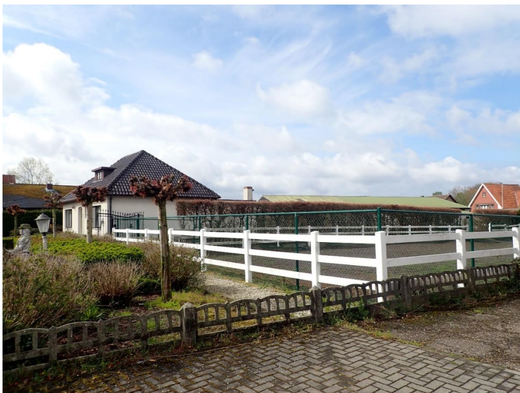
Figuur 5: Zicht op het plangebied vanuit het noordoosten.
