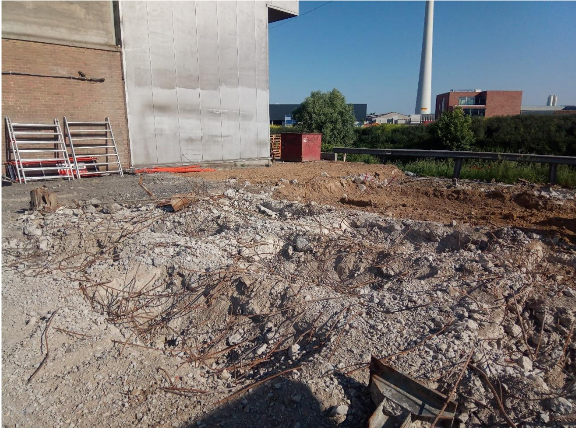
Figuur 5: Uitbraak van de vloerplaat van het westelijke gebouw
