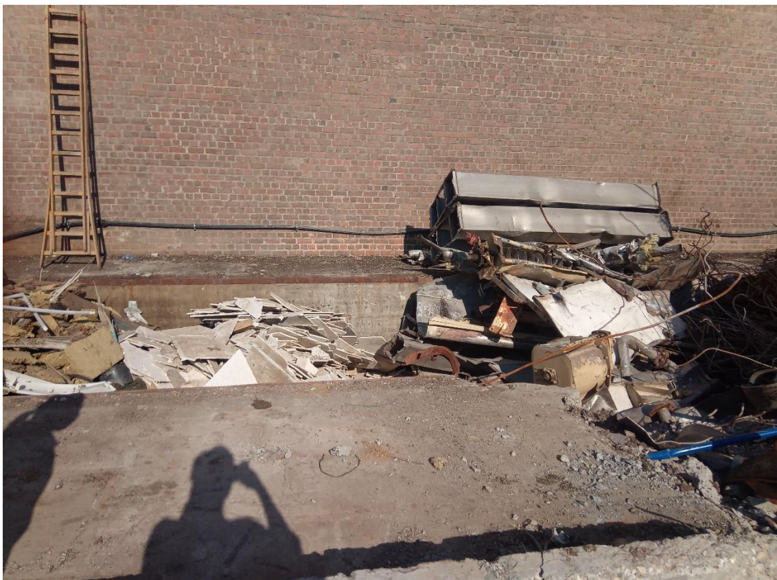
Figuur 4: Inspectieput in westelijke gebouw
