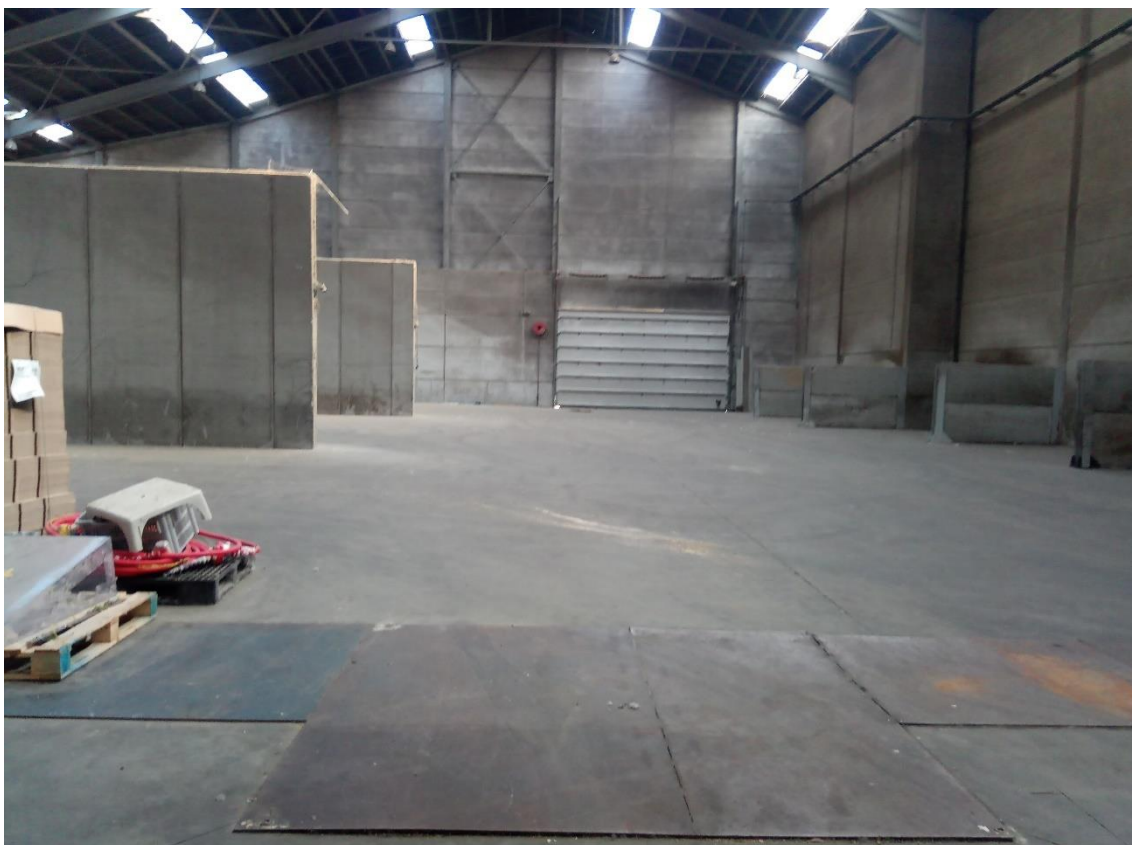
Figuur 7: Zicht binnenin het oostelijke gebouw
