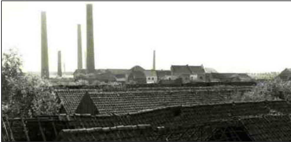
Figuur 17: Foto van de voormalige steenbakkerij voordat deze gesloopt werd in 1980 (foto is genomen in 1980 door de Vlaamse Gemeenschap via Beeldbank Onroerend Erfgoed ID: 150696).
