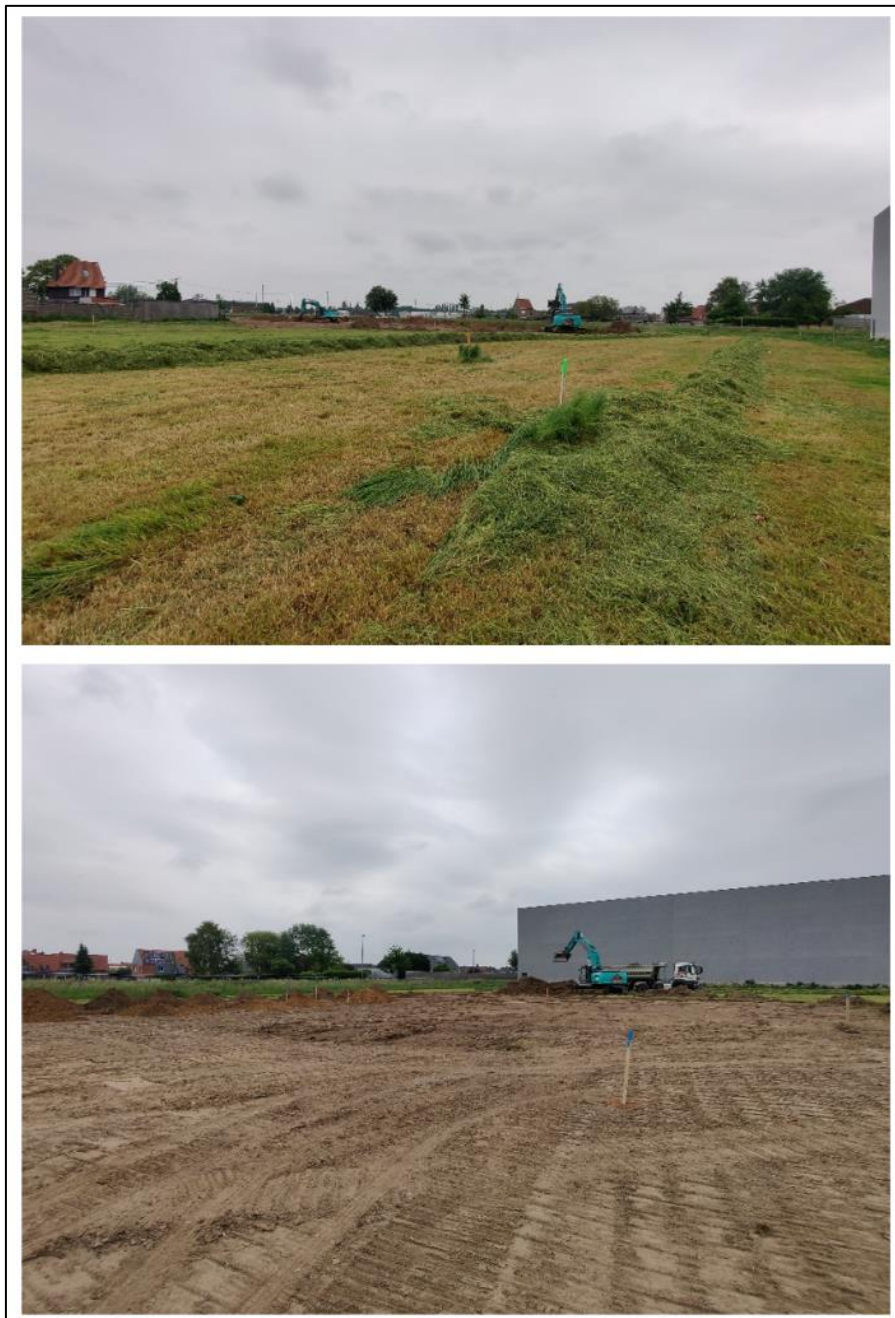
Figuur 8: Staat van het onderzoeksgebied bij uitvoering van het proefsleuvenonderzoek (ABO nv 2021)
