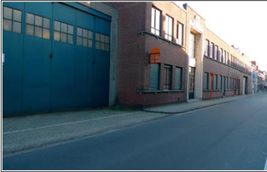
Figuur 11: Zicht op de westgevel van de bewaarde bebouwing langs de Bareelstraat (bron: Opdrachtgever 2017).
