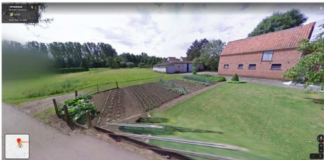
Figuur 6: Zicht op te behouden woning en te slopen gebouw vanop de Motstraat (Google Street View, juli 2009).
