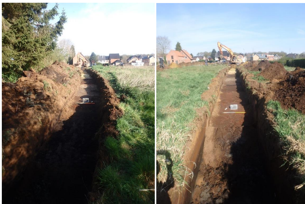
Figuur 20: Overzichtsfoto's van werkputten 3 (links) en 6 (rechts) met op de voorgrond de aangetroffen gracht (respectievelijk spoor 1 & spoor 26) (ARCHEBO bvba, 2021).
