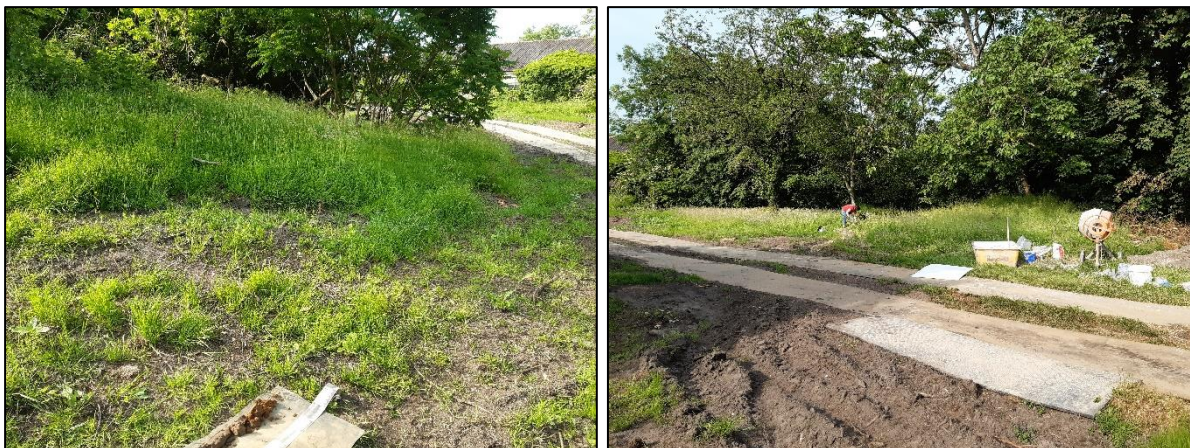
Figuur 7: Zicht op de ophogingen ter hoogte van boring 2 en 3.
