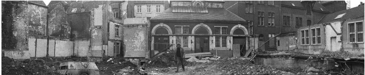
Figuur 16 Het projectgebied ten tijde van de sloop van de jongensschool in 1983. Achteraan zicht op de achtergevel van het stadsmagazijn (©stad Antwerpen | Stadsontwikkeling | Onroerend Erfgoed)
