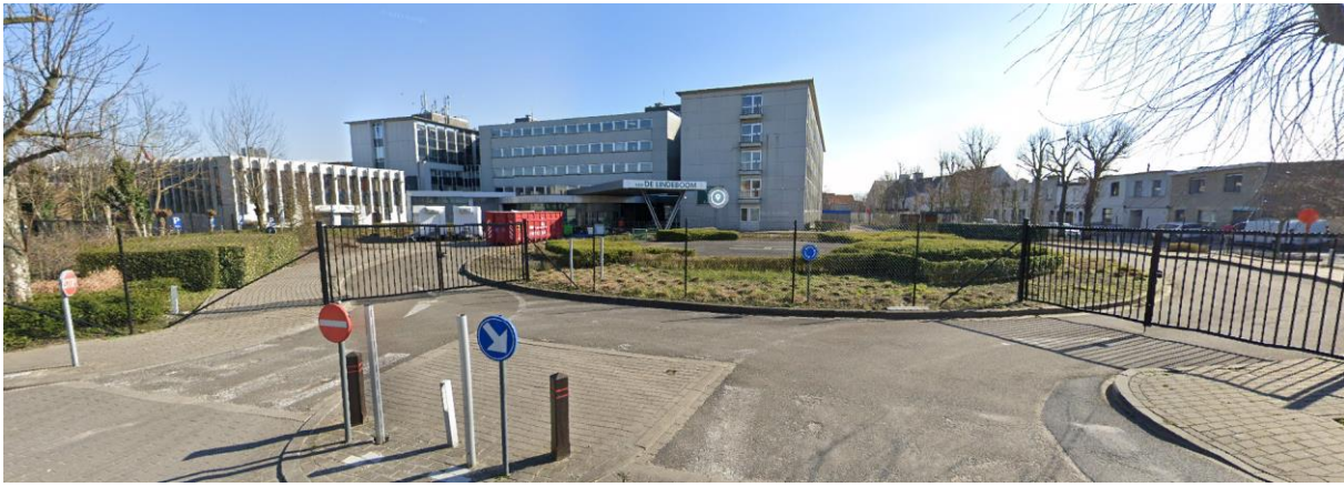
Figuur 4: Zicht op het hoofdgebouw en de rotonde vanaf de Graaf Jansdijk (Bron: Google Maps 2021)
