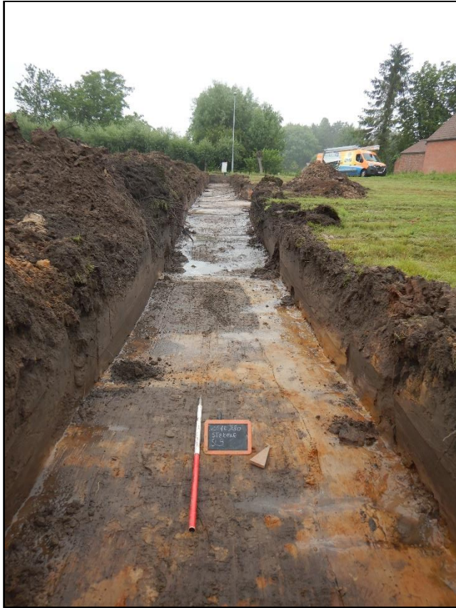
Figuur 20 Zicht op de verstoorde zone in het zuidelijke deel van sleuf 3.
