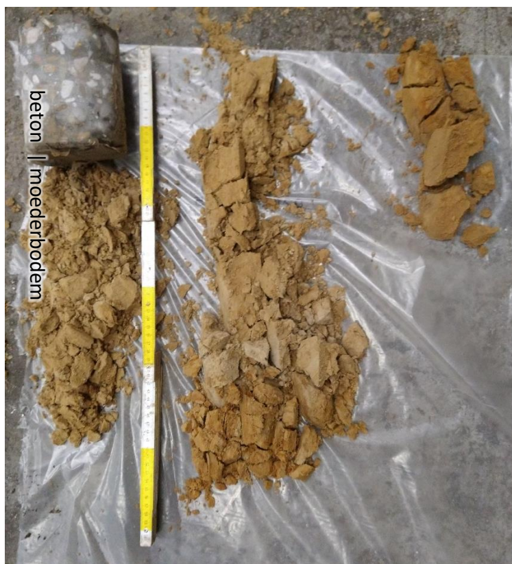
Figuur 6. Foto van boring 106, waar het beton direct op de moederbodem rust.
