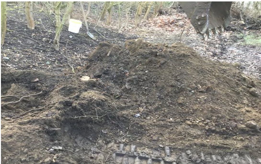
sleuf A1: uitgegraven materiaal
