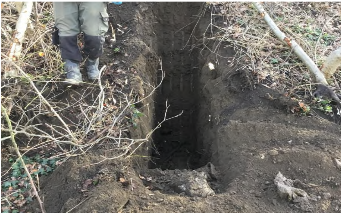
sleuf A2 (in talud)
