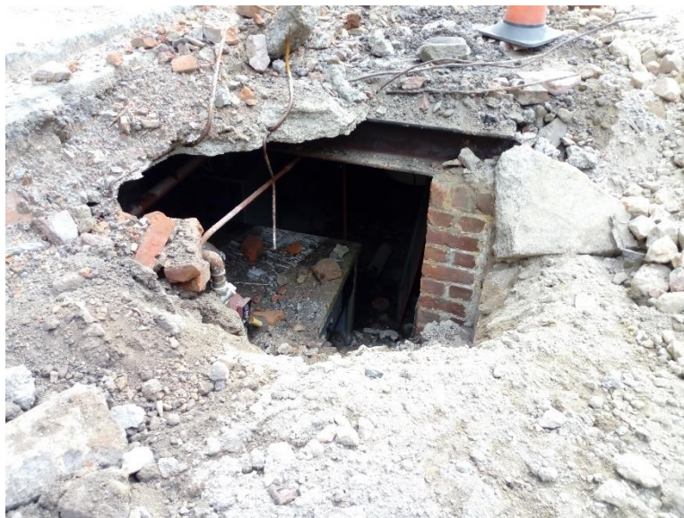
Figuur 3: Inzicht in aanwezige kelder in het noordoosten van het terrein.
