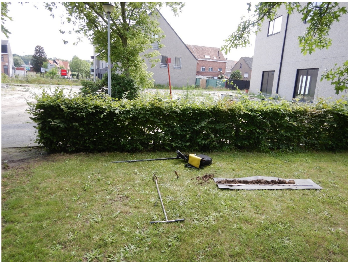
Figuur 13. Zicht op de locatie van boring 2.
