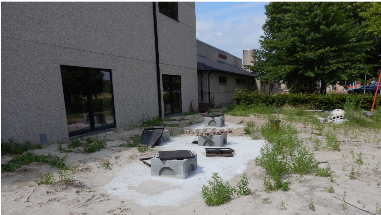
Figuur 2. Zicht op de septische en waterputten aan de voorzijde van de nieuwbouw.
