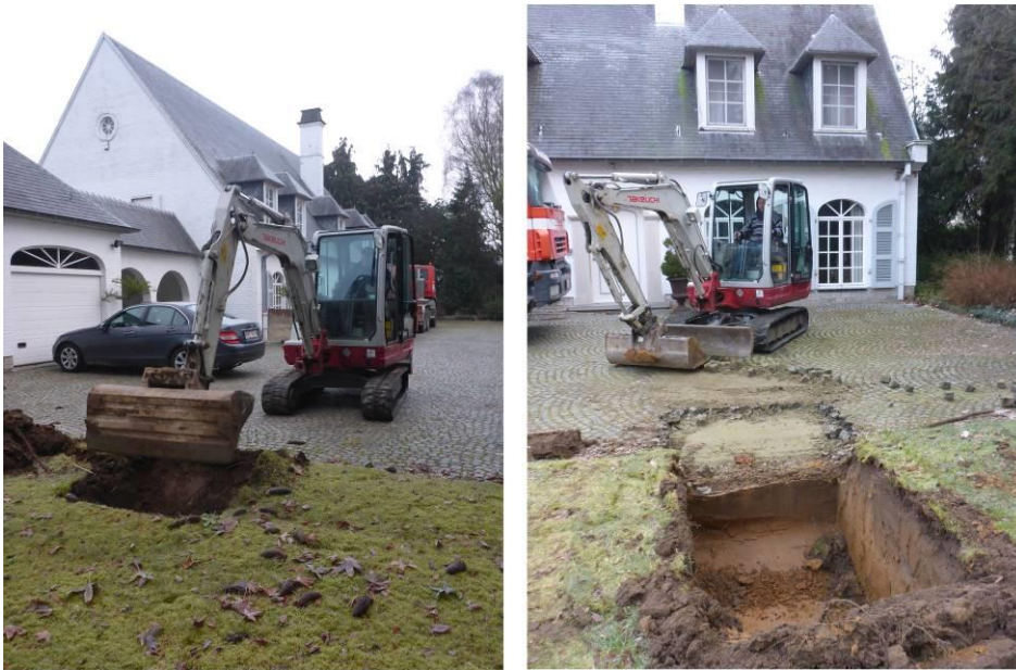
Fig. 20a en b: Het afgraven van respectievelijk profielput 1 en 2 (Bron: © GATE)
