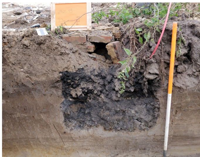
Afb. 15. Zicht op de fundering van de voormalige bebouwing op het westelijk deel van het terrein, waarbij zichtbaar is dat het gebouw op de oude akkerlaag is gefundeerd.
