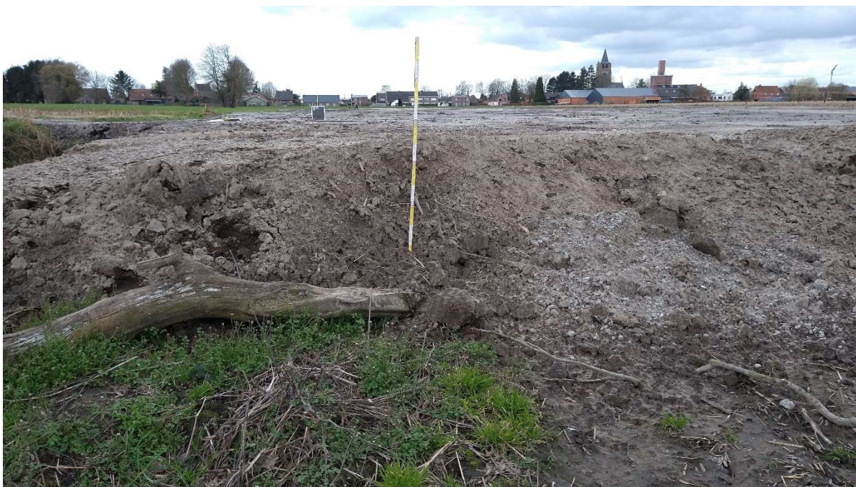
Figuur 10. Zicht op de opgehoogde grond ter hoogte van de reeds aangelegde riolering (zicht vanuit het oosten). ©LARES
