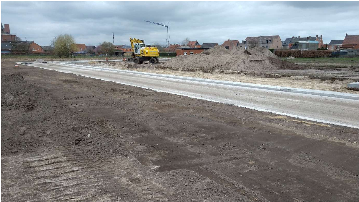
Figuur 8. Zicht op de reeds aangelegde weg die reeds bij een ander vooronderzoek is onderzocht. ©LARES
