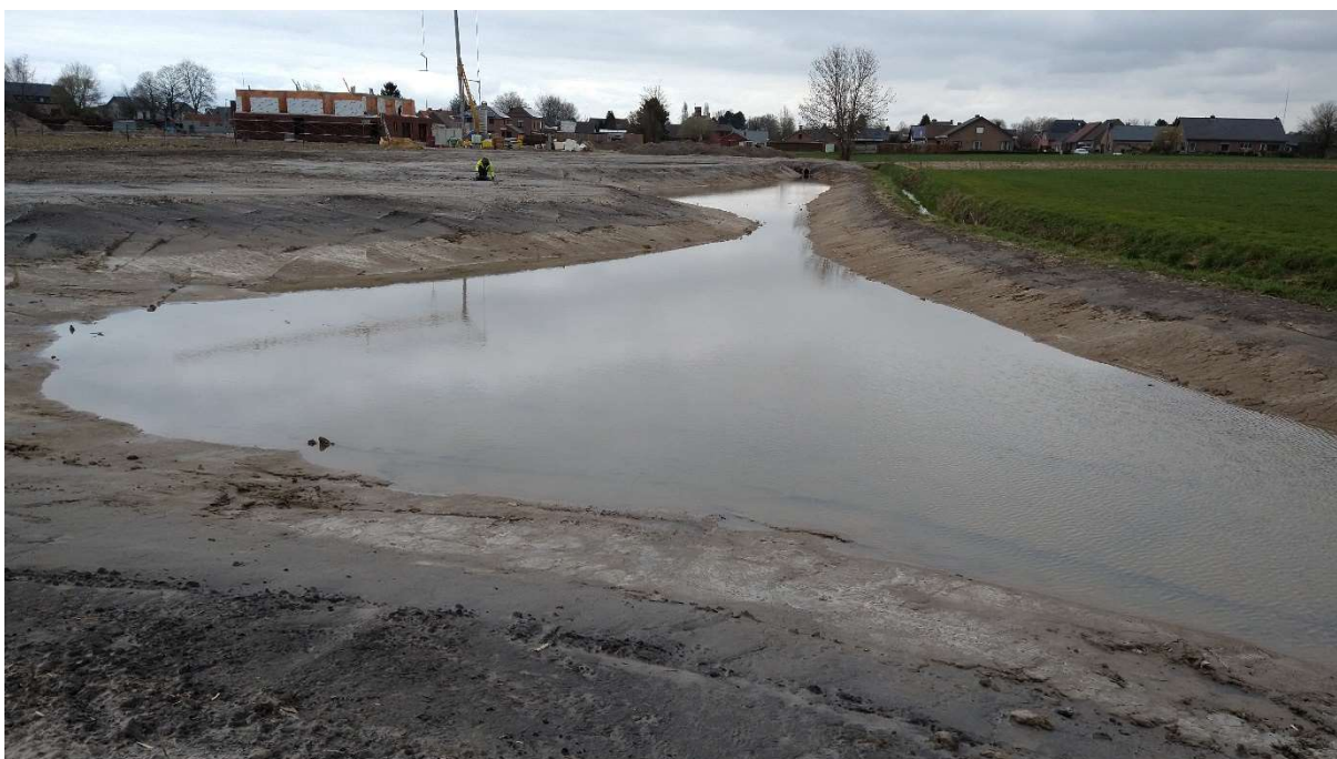
Figuur 11. Zicht op het reeds gegraven bufferbekken ter hoogte van de Stratenloop (zicht vanuit het zuidwesten). ©LARES
