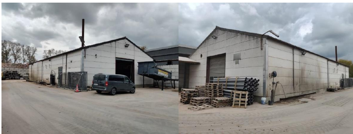
Figuur 4: Foto's te slopen loods 7
