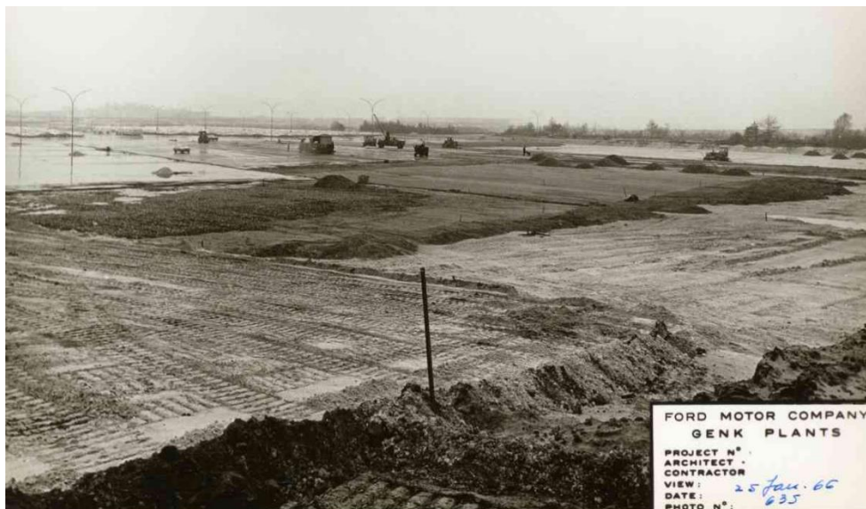
Figuur 9: Ophogings- en funderingswerkzaamheden op de site in 1966. (Bron: Opdrachtgever 2020).
