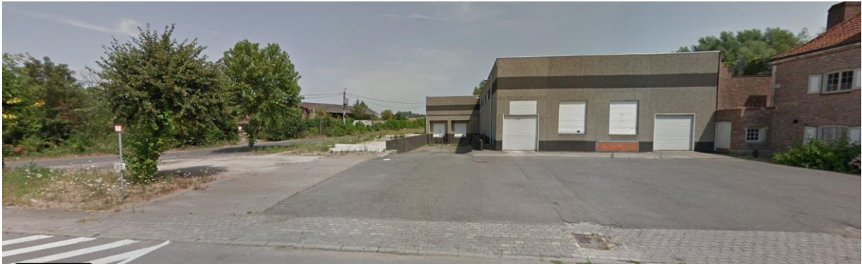
Figuur 1: Bestaande toestand voorzijde (kant Statiestraat kijkend naar het noorden) 2
