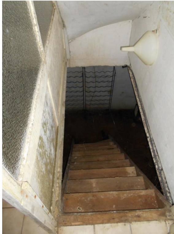
Figuur 4: Toegang van kelder ter hoogte van huisnummer 72 in nieuwe zone 4. 23
