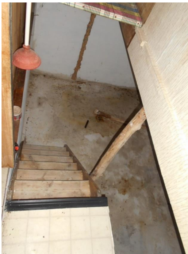
Figuur 3: Toegang naar kelder ter hoogte van huisnummer 70 in nieuwe zone 4. 22
