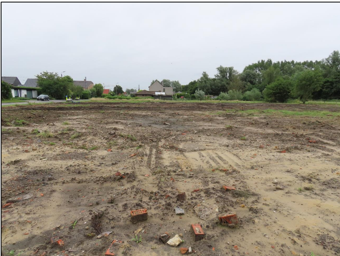
Figuur 2 Zicht op het oosten vanuit het westen na sloop van de gebouwen.
