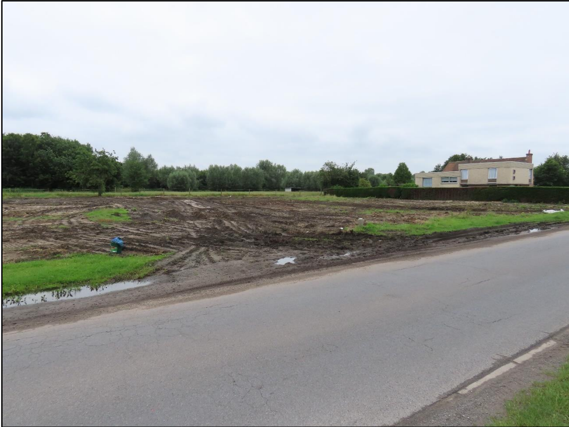
Figuur 1 Zicht op het zuidelijk deel van het plangebied vanuit het noorden na sloop van de gebouwen.
